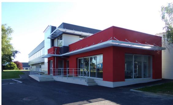
L'isolation thermique des bureaux a été revue par la pose de nouvelles menuiseries, le renforcement de l'isolation des parois et le changement des bardages.
