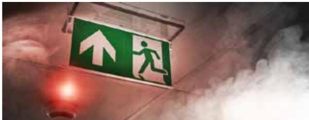
**En cas de coupure générale**, il est nécessaire de disposer d'un système d'éclairage de sécurité permettant d'indiquer le passage où se situent les portes d'évacuation. Il faut que cette signalisation dans les locaux soit visuelle et éclairée, comme le stipule le règlement. Car au-delà d'être un éclairage de sécurité, ces équipements assurent la protection des personnes et permettent aussi de sauver des vies.
