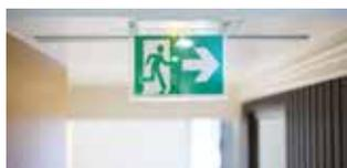
C'est pourquoi, il est nécessaire d'en disposer d'un nombre suffisant afin de mieux contrôler la circulation des personnes en cas d'évacuation. De même, en plus d'être autonome et de ne consommer quasiment aucune énergie électrique, leur entretien repose uniquement sur la vérification des lampes et de l'autonomie des batteries.
