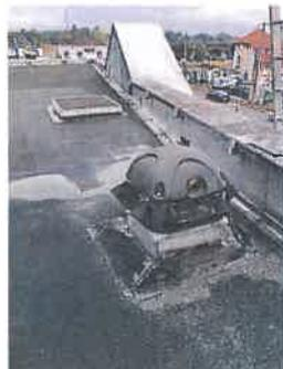
La/les sortie(s) en traversée de toiture ne présente(nt) pas de défauts apparents.
