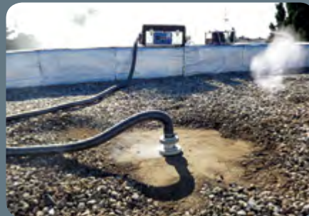
Recherche de fuite avec fumigène
