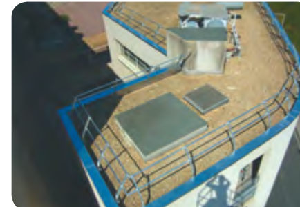
Pose de gardes-aux-corps
