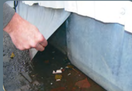
Contrôle de l'étanchéité
