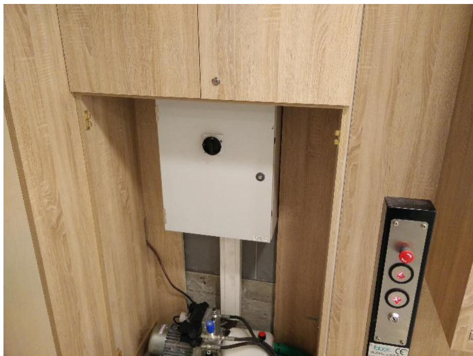
Vue d'exemple du groupe hydraulique , de la centrale de commande et de la fosse de réservation.
