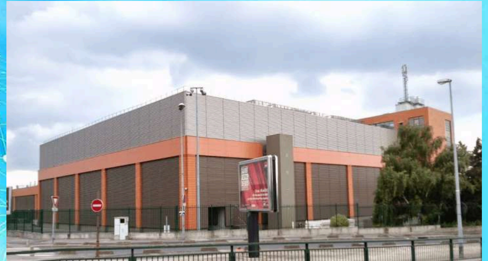
Equinix PA3 Saint Denis (93)
