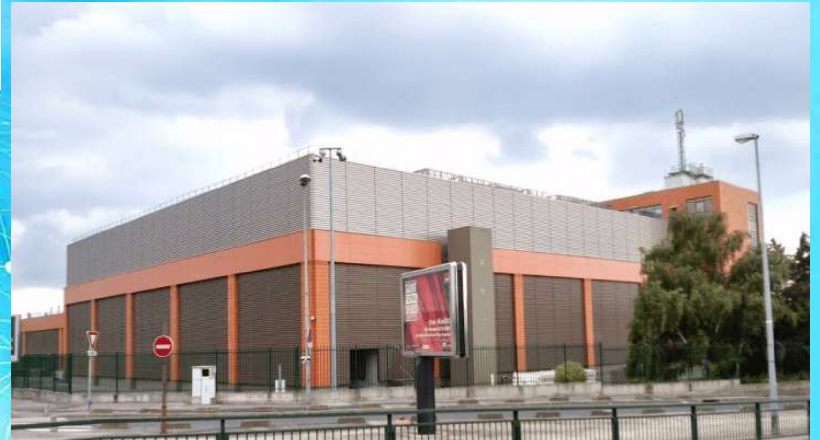
Equinix PA3 Saint Denis (93)
